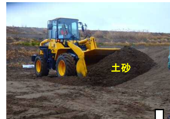
重機により土砂を撤去
