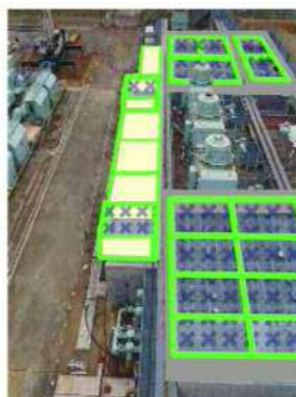
海水ポンプ室
