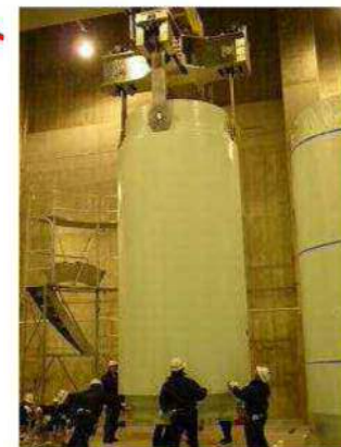
⑤ 乾式キャスクの移動作業
