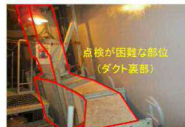
例 ダクト裏部
