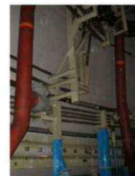
仮設足場組立前
