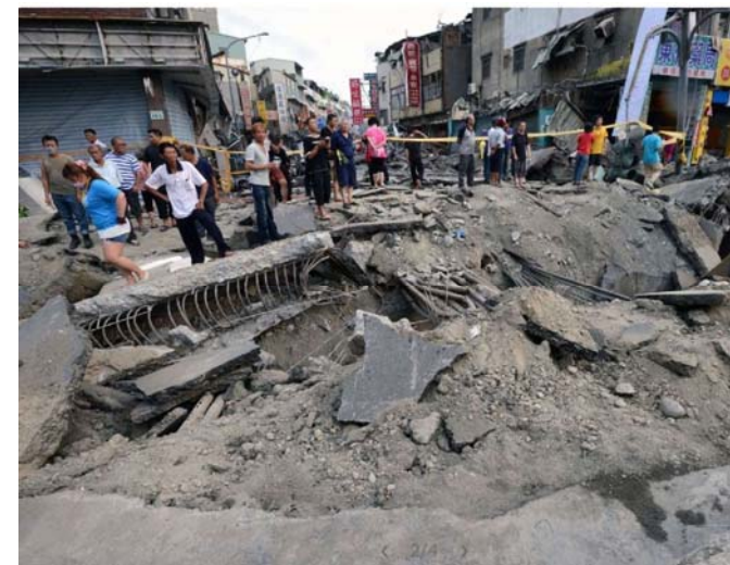
ガス爆発現場の状況
