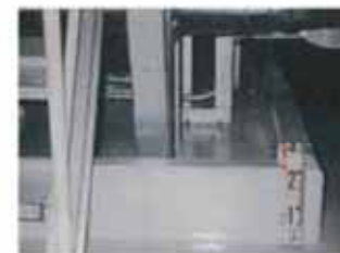
防油堤の設置
