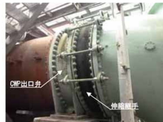
図6. 16 循環水ポンプ出口管及び伸縮継手
