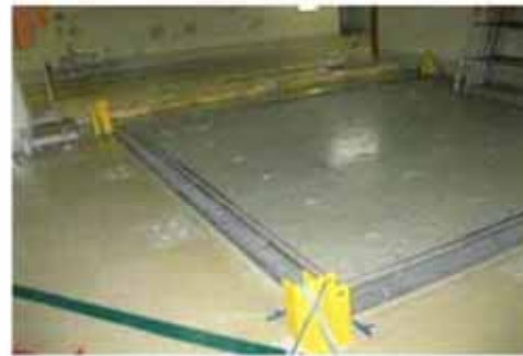
支柱レールの取付状況例
