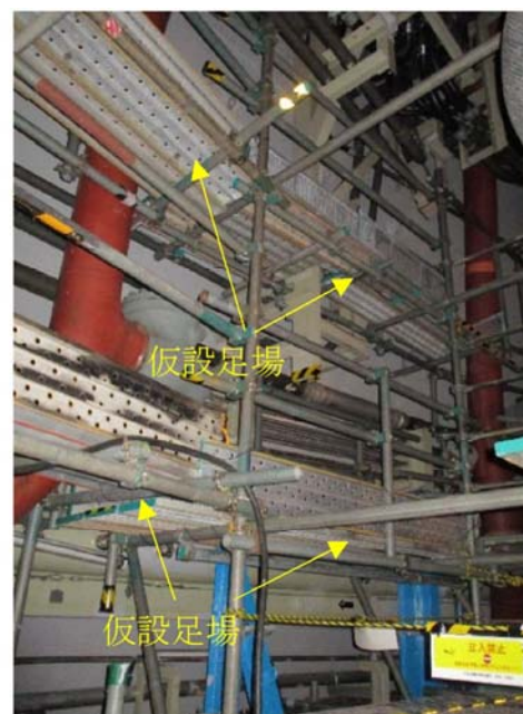
仮設足場組立後
