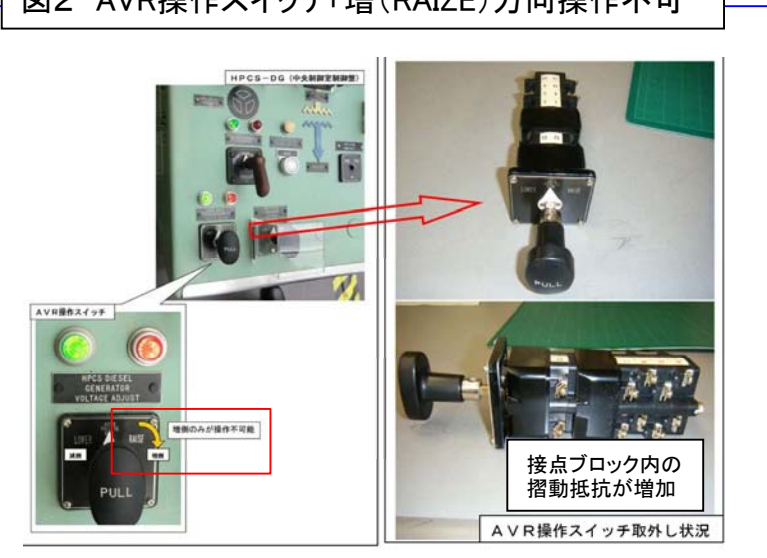
図2 AVR操作スイッチ「増(RAIZE)」方向操作不可
