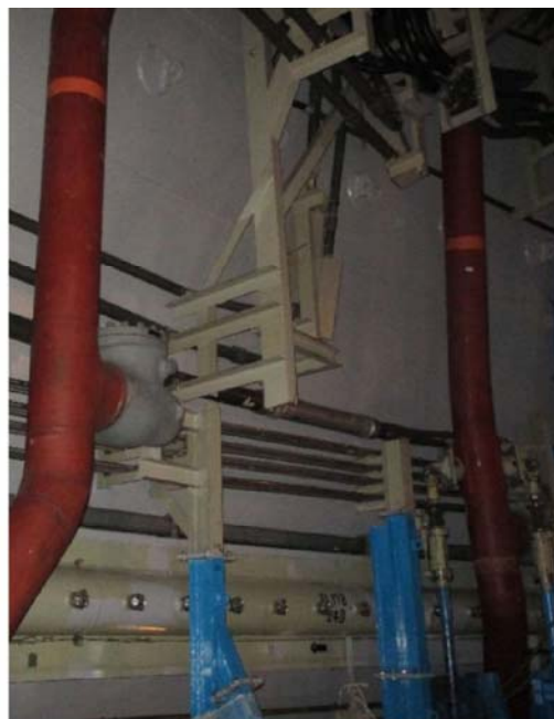
仮設足場組立前
