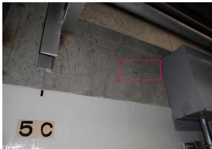
原子炉建屋3階壁面
