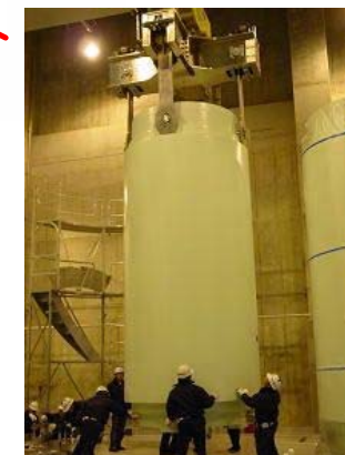
⑤ 乾式キャスクの移動作業
