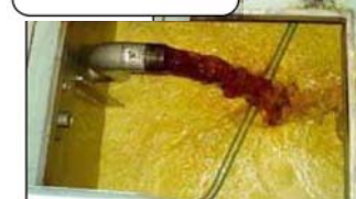
写真② 主油タンク油面(泡)
