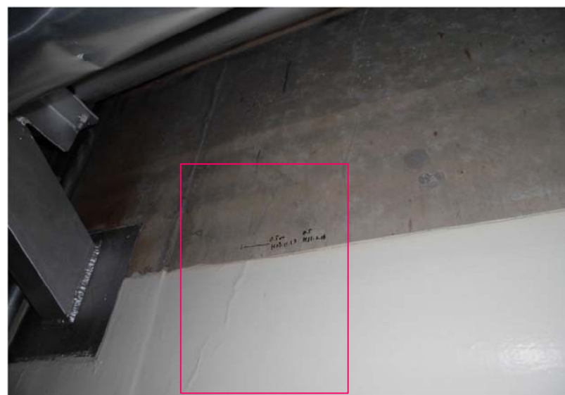
原子炉建屋5階壁面
