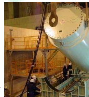
④ 建屋内でのキャスクの立起し作業 論点No.179-16
