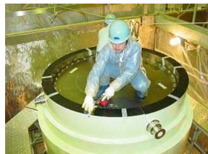
② 原子炉建屋除染ピットでの一次蓋ボルト締め付け作業
