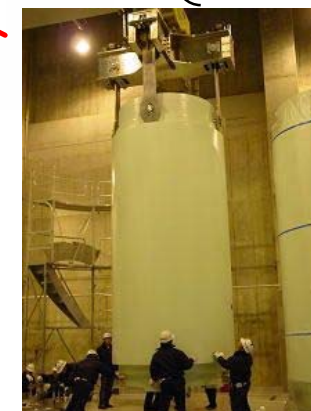
⑤ 乾式キャスクの移動作業
