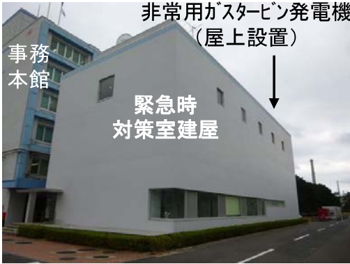
緊急時対策室建屋 (当時施工中)*
