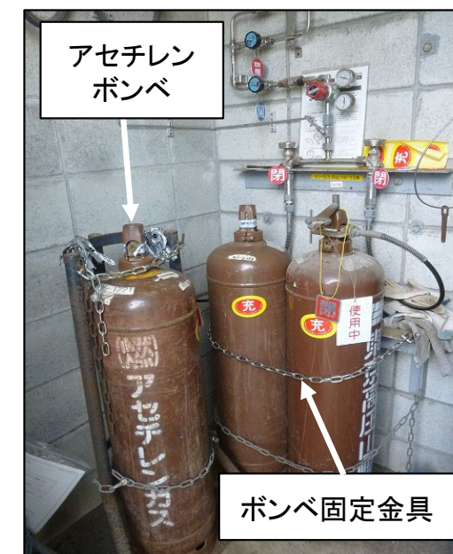
図18 敷地内におけるボンベの設置状況
