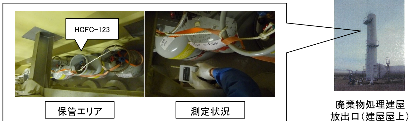
図21 建屋内風速の測定状況
