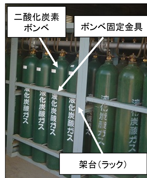
図18 敷地内におけるボンベの設置状況
