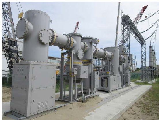
ガス絶縁開閉装置への設備変更
