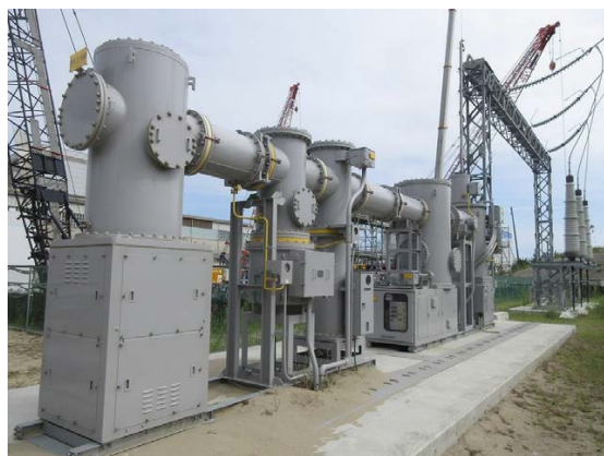
ガス絶縁開閉装置への設備変更
