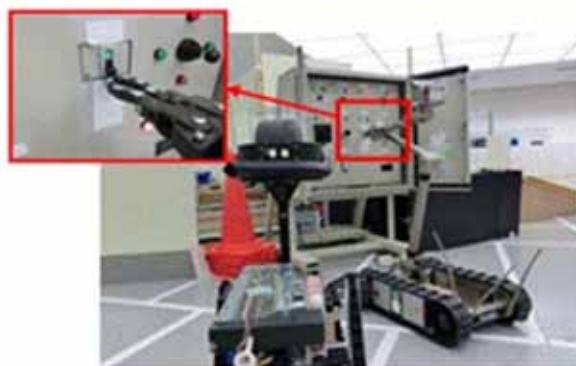
制御盤を開放しスイッチ操作
