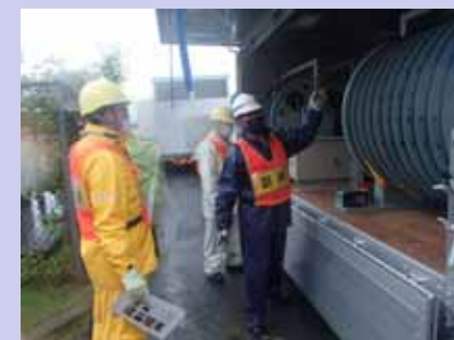
降雨時の電源車の設置・運用
