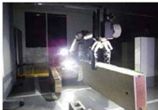
暗闇での障害物撤去
