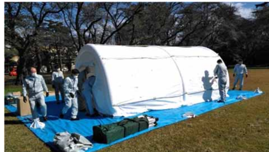
支援拠点設営（エアテント設置）
