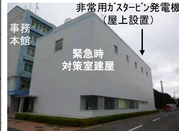
緊急時対策室建屋 (当時施工中)*
