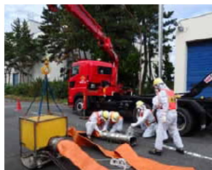
( 実機による訓練 )可搬型代替注水ポンプ車の設置・運用
