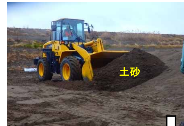
重機により土砂を撤去
