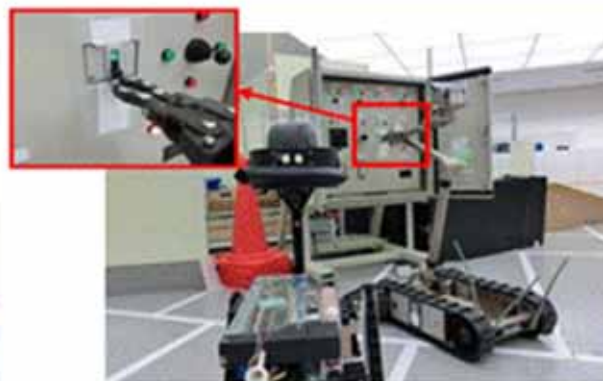
制御盤を開放しスイッチ操作
