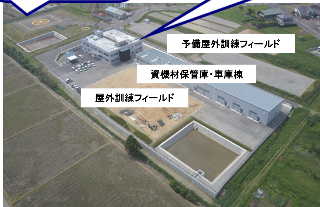
美浜原子力緊急事態支援センター拠点施設の全景 緊急体制-56
