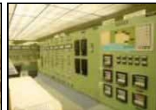
④外部電源系統及び 環境監視盤
