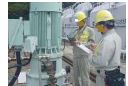
【直営での回転機振動測定】
