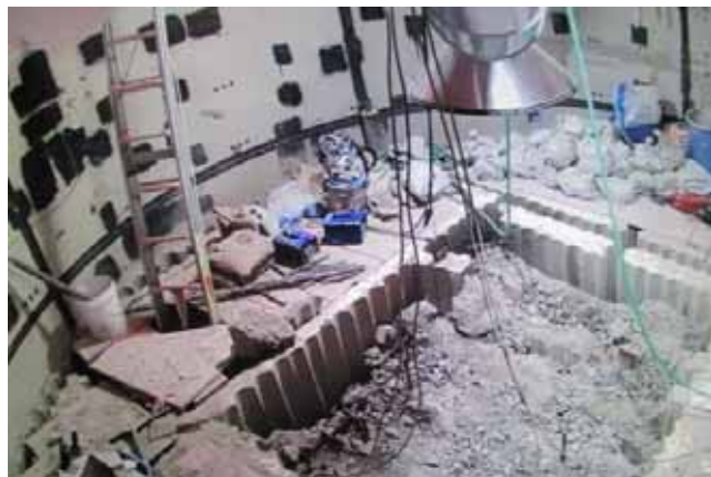
図2 既存床コンクリートはつり作業
