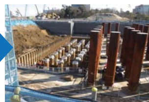
地盤改良工事・鋼管杭打設
