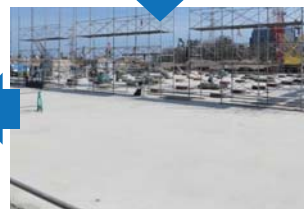
コンクリート打設
