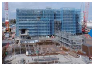
建屋躯体構築
