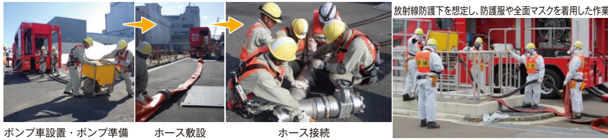
図2 水源確保訓練の様子 緊急時に大容量ポンプ車を用いて、原子炉や使用済燃料プールへ給水するための訓練です。
