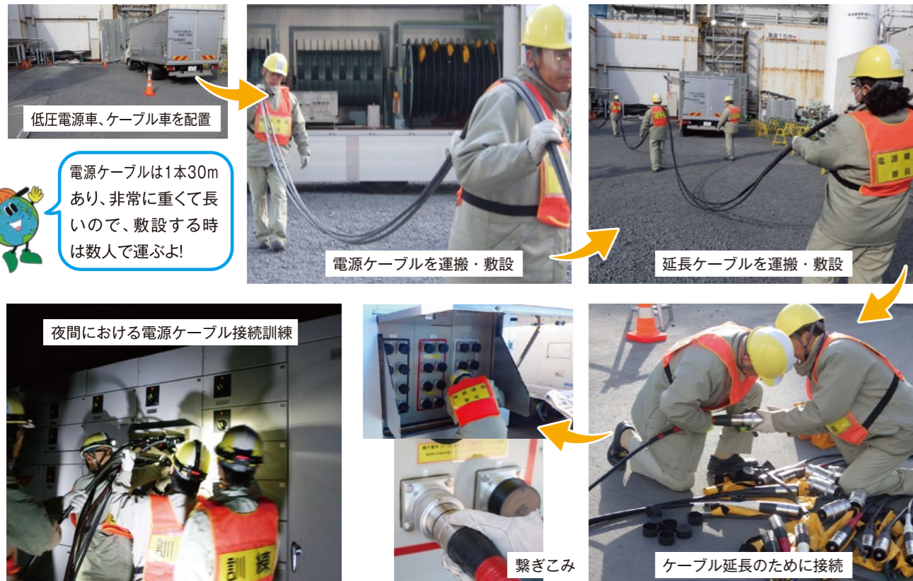
図3 電源確保訓練の様子 緊急時に電源ケーブルを接続し、原子炉の冷却に必要な電源を確保する訓練です。
