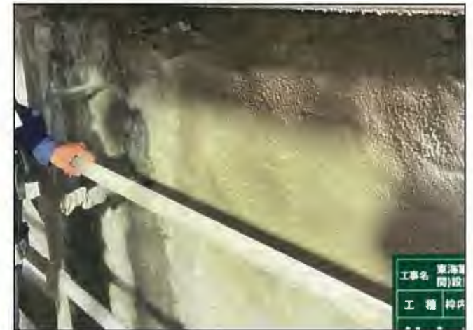
吹付後（整備後）の地中連続壁（中実部側）
