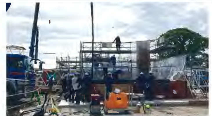
コンクリート打設状況（全景）
