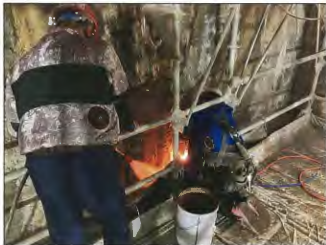
鉄筋切断状況
