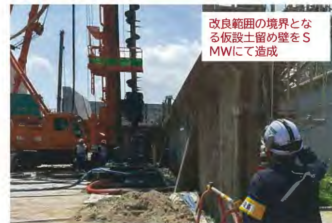
仮設土留め壁の造成（北基礎）
