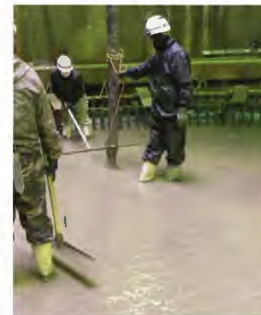
コンクリート打設
