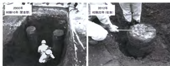
写真2 改良体の掘起し状況
