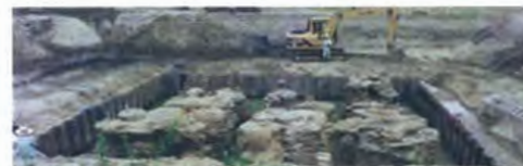
写真-1 開削状況
