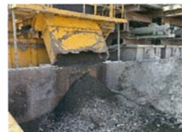
サクションプンプによる土砂回収
