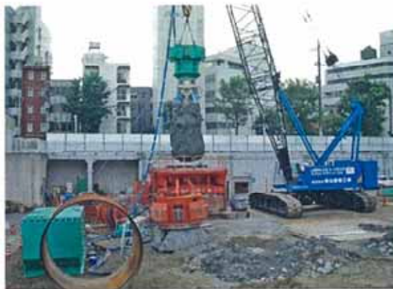
A-CR工法（アブソリュート・クラッシング工法）：横山基礎 HP より
