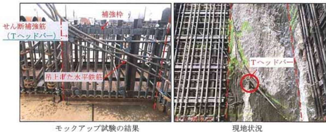
図 5.3-38 モックアップ試験の結果（後行エレメント水平鉄筋の変形）と現地状況
