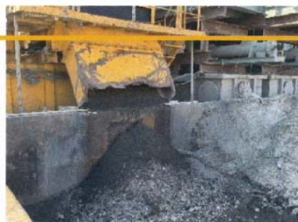
サクションプンプによる土砂回収
