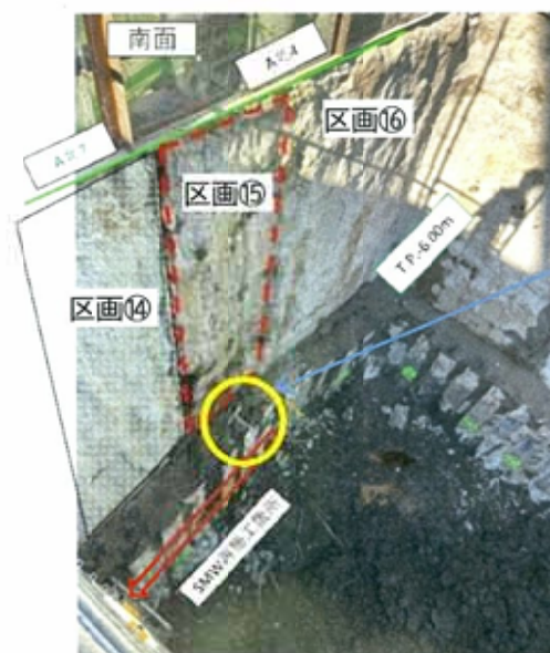
再構築したSMWの掘削時の状況写真
