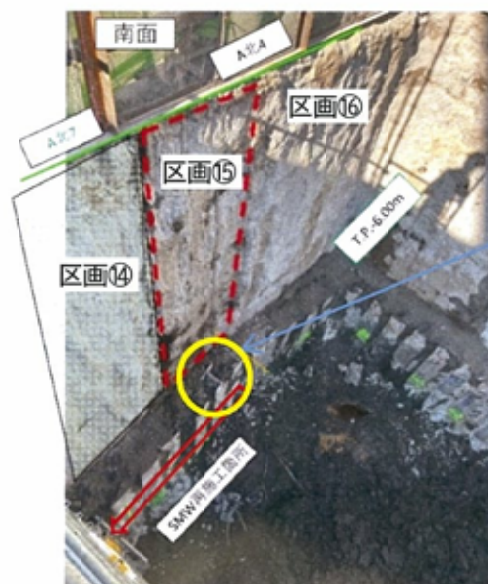
再構築したSMWの掘削時の状況写真
