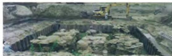
写真-1 開削状況
