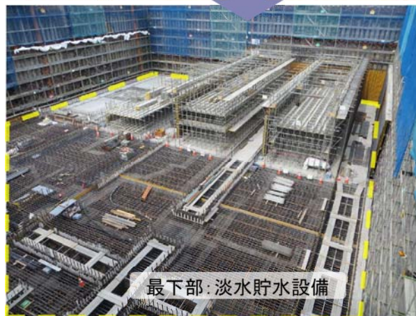
鉄筋及び コンクリート打設
