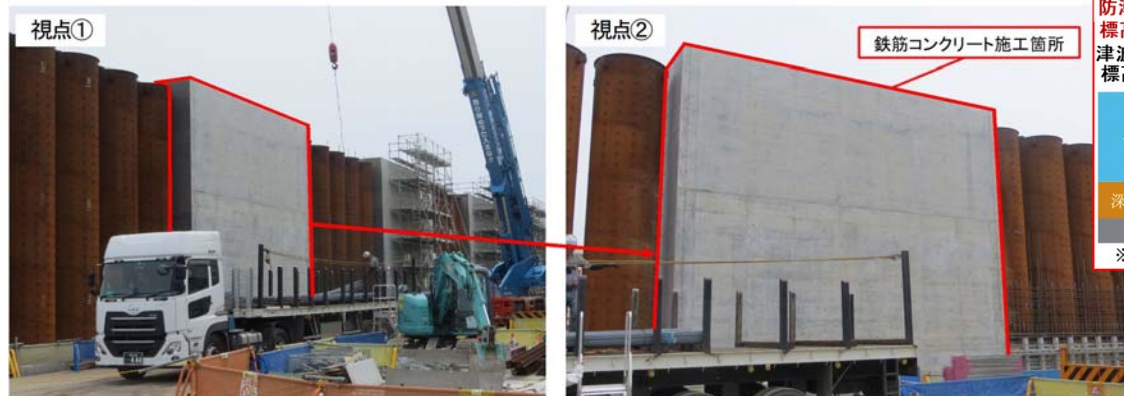
防潮堤（北側）の状況
