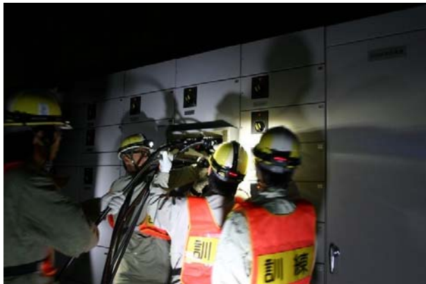
電源ケーブル接続訓練 (夜間訓練)
