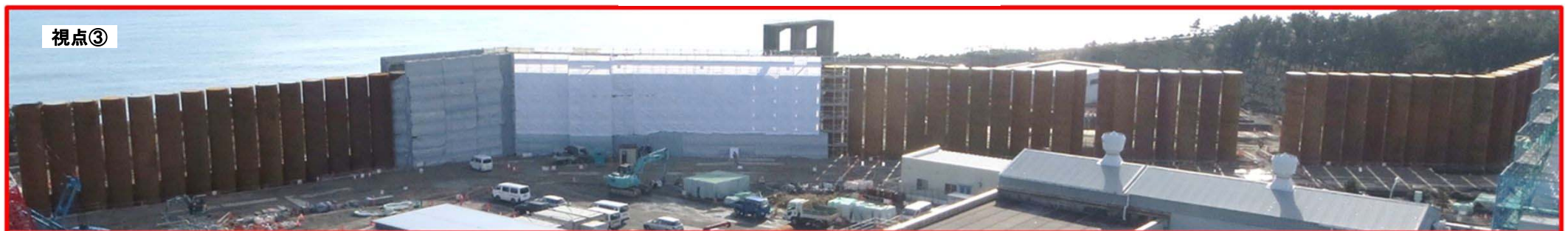
防潮堤（南側）の状況
