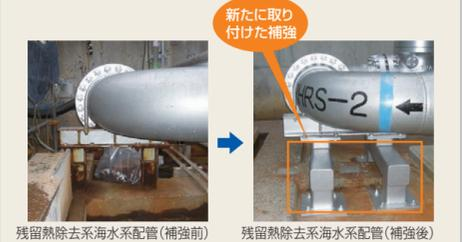
残留熱除去系海水系配管(補強前) 残留熱除去系海水系配管(補強後)
