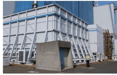
非常用ディーゼル発電機の給排気設備を津波から守る防護壁(高さ約8m)
