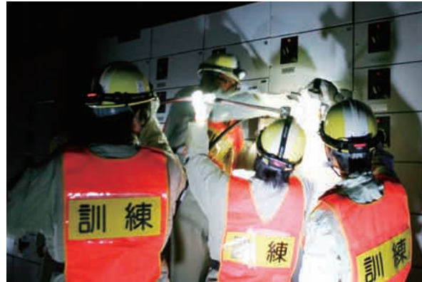
電源繋ぎ込み訓練（夜間訓練）
