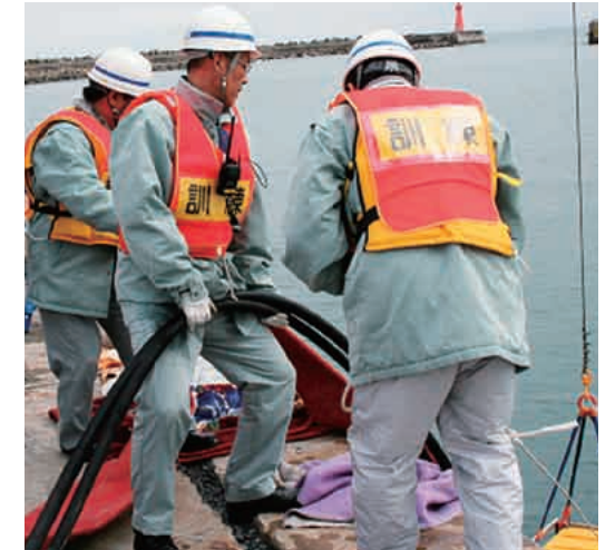
送水ポンプの海中投入・送水訓練
