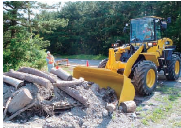
重機（ホイールローダ）による、障害物の撤去訓練
