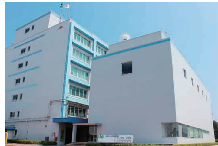
災害対策本部が置かれている免震棟（右側）
