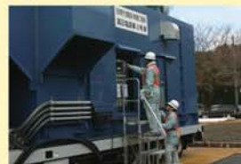
高圧電源車の起動訓練
