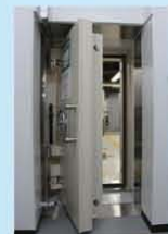
水密扉(開放状態)
