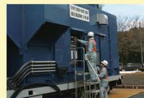
高圧電源車の起動訓練
