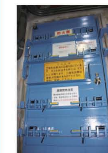
建屋扉の強化・密封化
