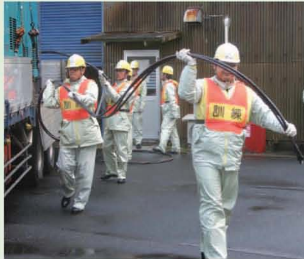
所内電源盤までの電源ケーブル敷設訓練
