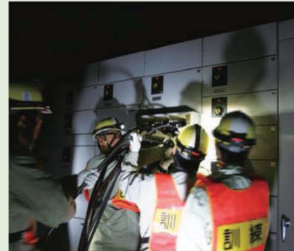
所内電源盤への電源ケーブル接続訓練(夜間訓練)
