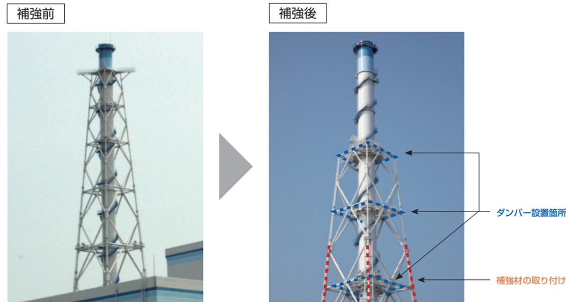
**●非常用ガス処理系配管の支持の強化**
