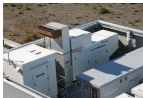
緊急時対策室建屋屋上に設置したガスタービン発電装置
