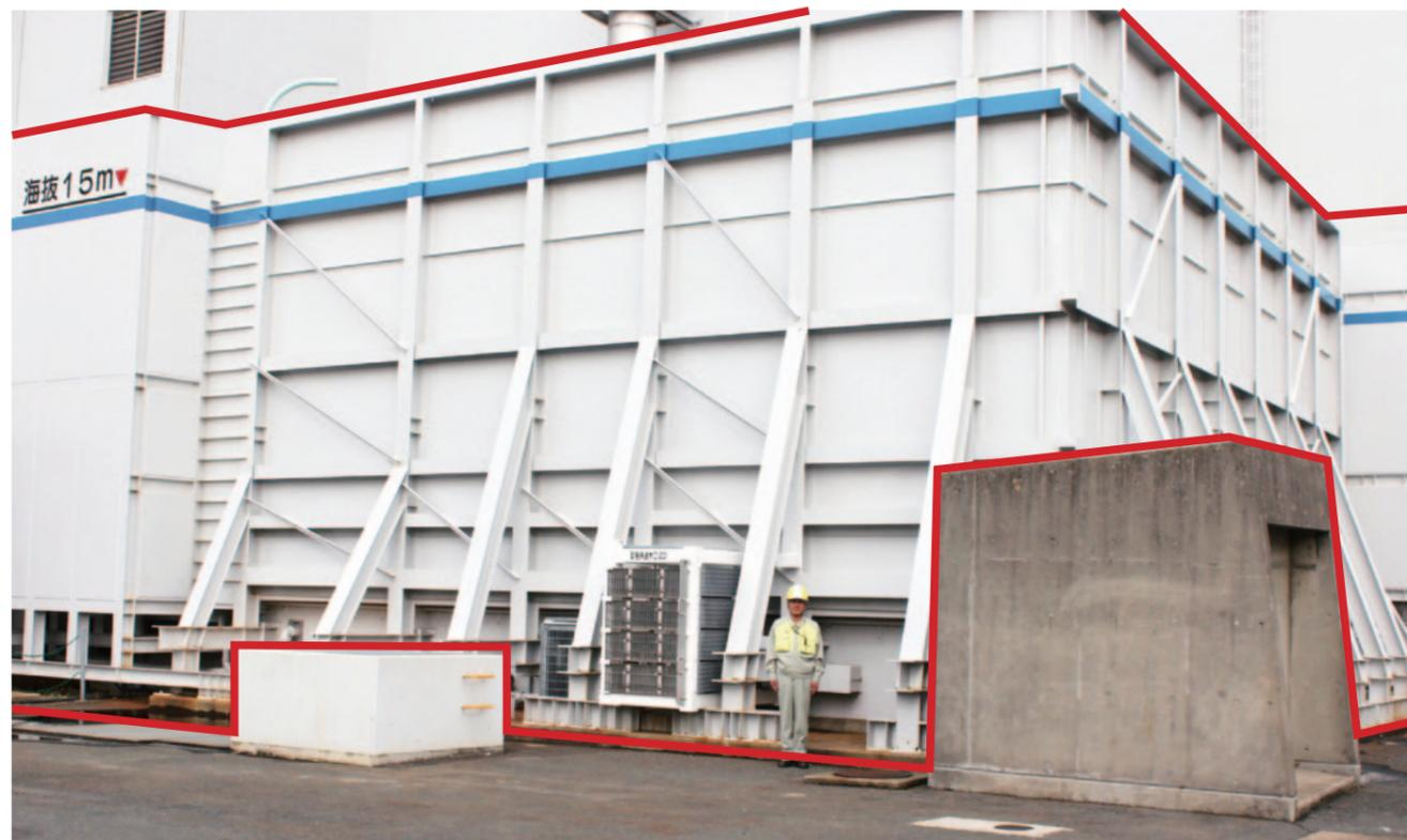
非常用ディーゼル発電機の給排気設備の外側に設置した防護壁
