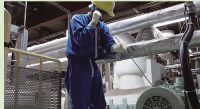
振動音を聞いてモーターの状態を確認
