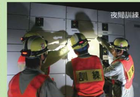
① 電源車の起動および電源ケーブル繋ぎ込み訓練
