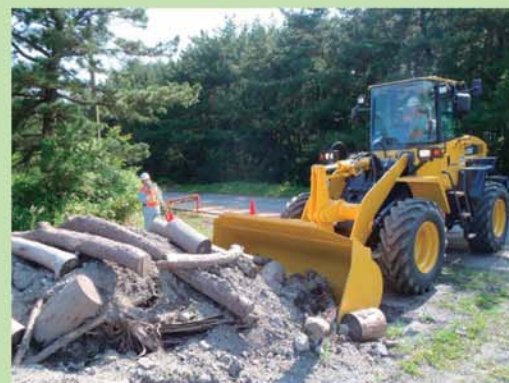
③ がれきを除去する重機（ホイールローダ）の操作訓練
