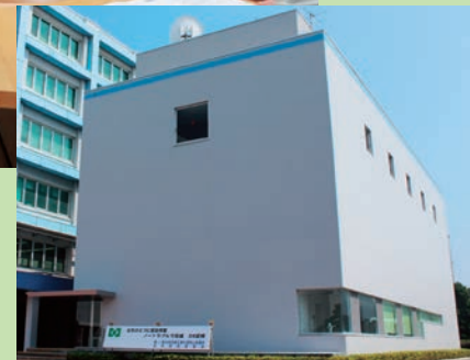
免震構造の緊急時対策室建屋
