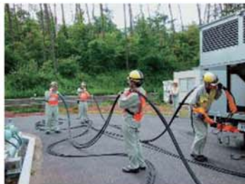
低圧電源車から電源盤への敷設訓練
