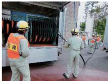
低圧電源車から電源盤への敷設訓練
