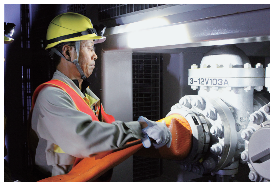
専用配管接続口にホースを繋ぎ込む訓練 (夜間)
