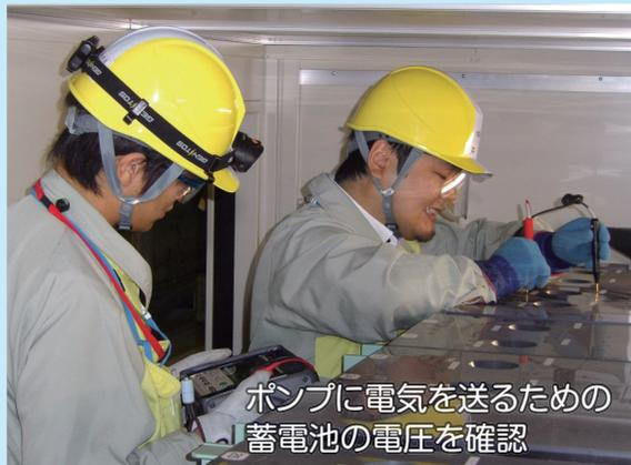
ポンプに電気を送るための蓄電池の電圧を確認
