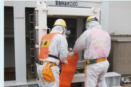
③建屋の専用配管口にホースを接続し、冷却水をディーゼル発電機に供給できることを確認
