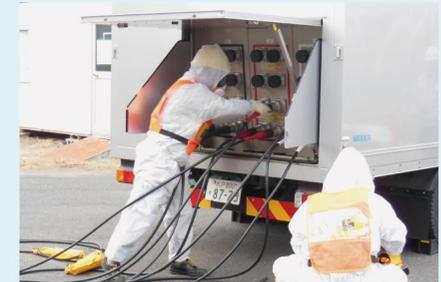
低圧電源車を起動し、原子炉に冷却水を注水するポンプに電気を供給できることを確認
