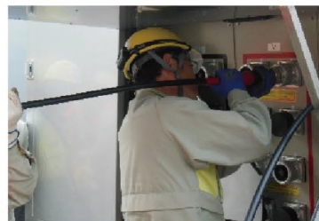
低圧電源車にケーブルを接続し、現場の電源盤に電気を供給
