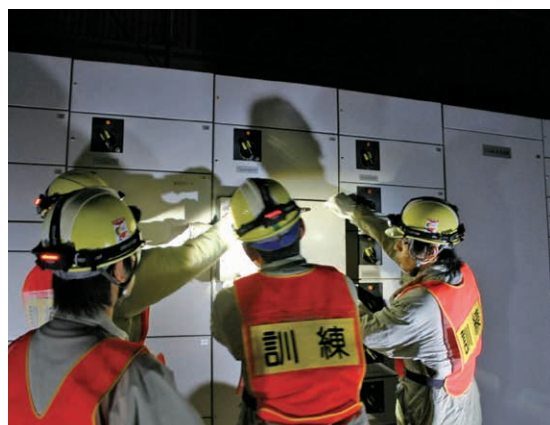
電源確保夜間訓練
