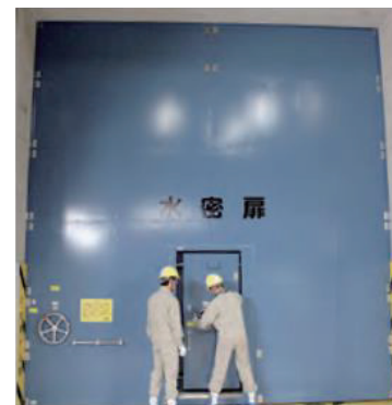
安全上重要な設備への浸水を防止(水密扉)
