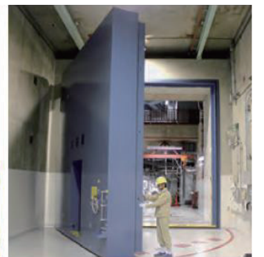
安全上重要な設備への浸水を防止(水密扉)
