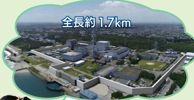
防潮堤は、発電所周辺を高さ20m、全長約1.7kmの壁で囲い、津波の浸水を防止します。
