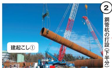
② 鋼管杭の打設(下半分)
