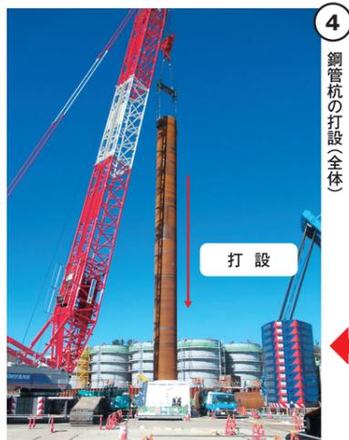
④ 鋼管杭の打設(全体)
