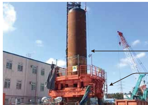
鋼管杭の打設の様子(図2-1)
