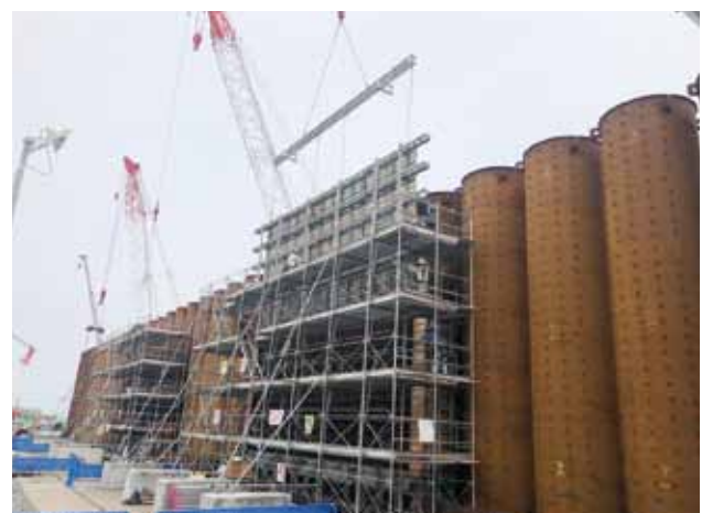
地上部鋼管杭へのユニット型枠設置の様子(図5)
