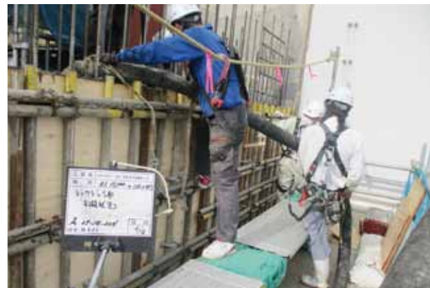
コンクリート注入の様子(図2)
