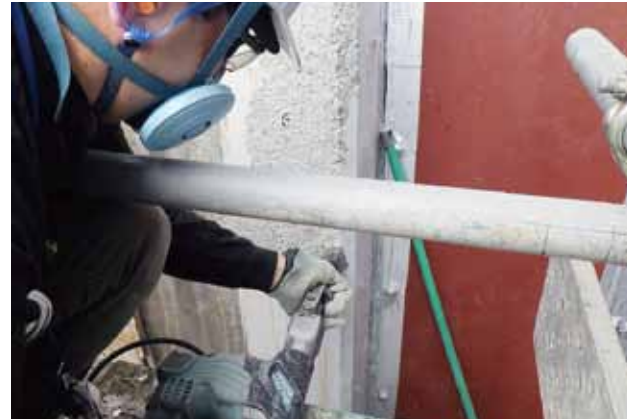
削岩機での目荒らし(図1)
