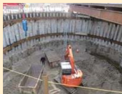
土留め壁を造成、掘削
