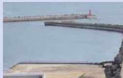
工事中(土地埋立)
