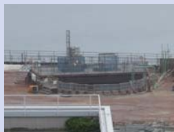
取水塔:地下約30m、直径約14m
