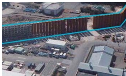
防潮堤の設置が進む東海第二発電所
