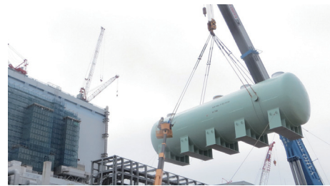
重油貯蔵タンクを設置中(図4)
