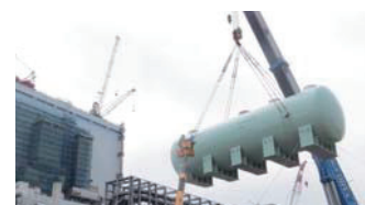
重油貯蔵タンクを設置中(図4)
